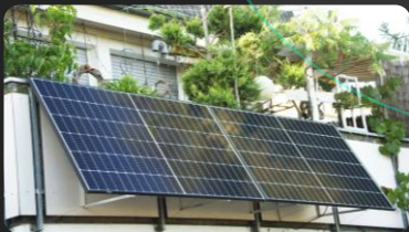
Stockage sur balcon
