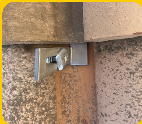
Platine/ Crochet de fixation pour tuiles - Modèle inversé (rails verticaux - Panneaux solaires en paysage)
